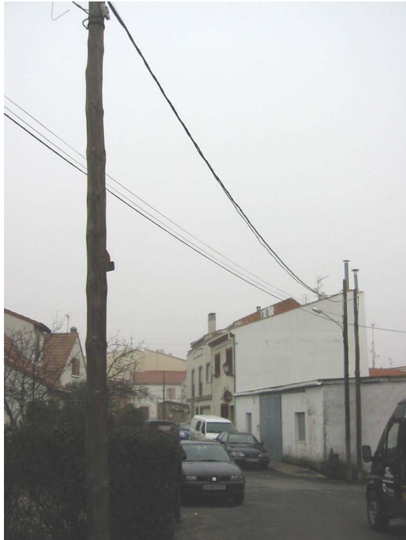
VISTA DE LAS CONEXIONES AEREAS EXISTENTES A LA ZONA DEL CASCO URBANO
