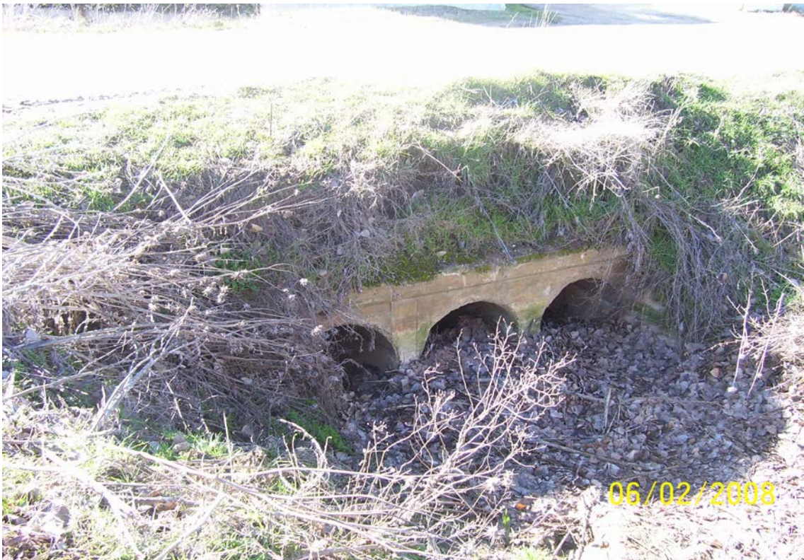
Obra de fábrica bajo camino en límite inferior del sector
