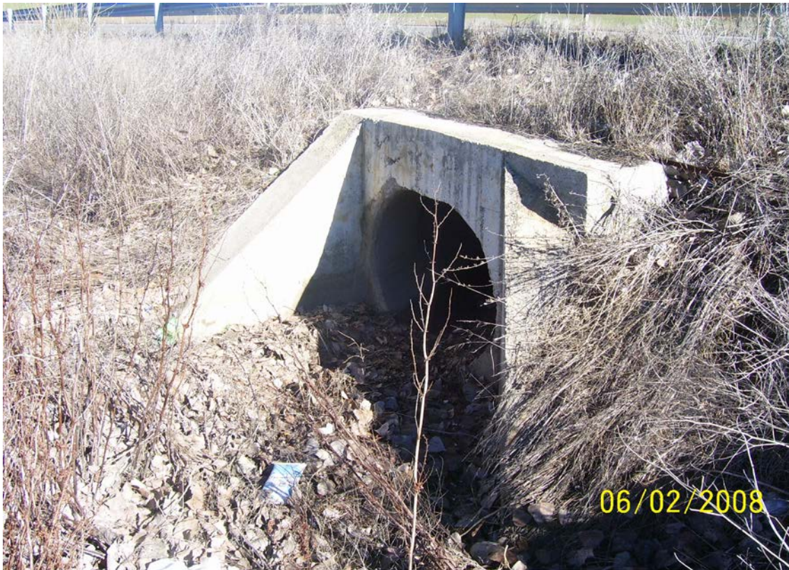
Obra de fábrica en carretera
